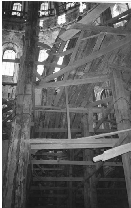
Строительные леса в ротонде собора
